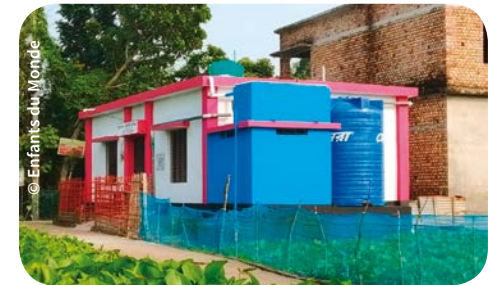
Vorher-nachher-Aufnahmen: Eine sanierte Gesundheitseinrichtung für die breite Bevölkerung
